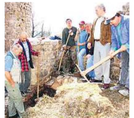
2004 legten die Arbeiter das Kastenhäus frei.
